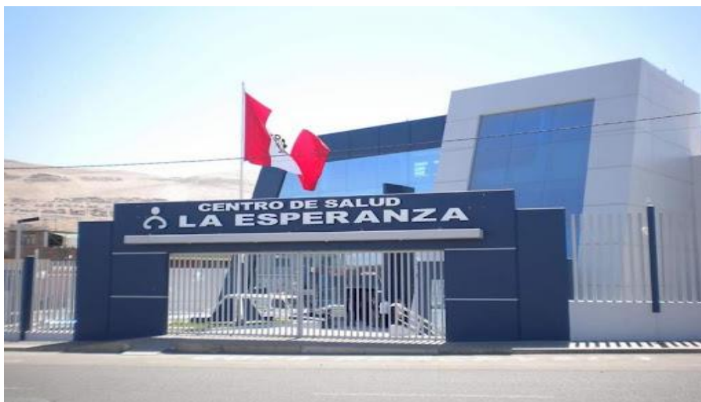
Fachada del centro de salud La Esperanza.
