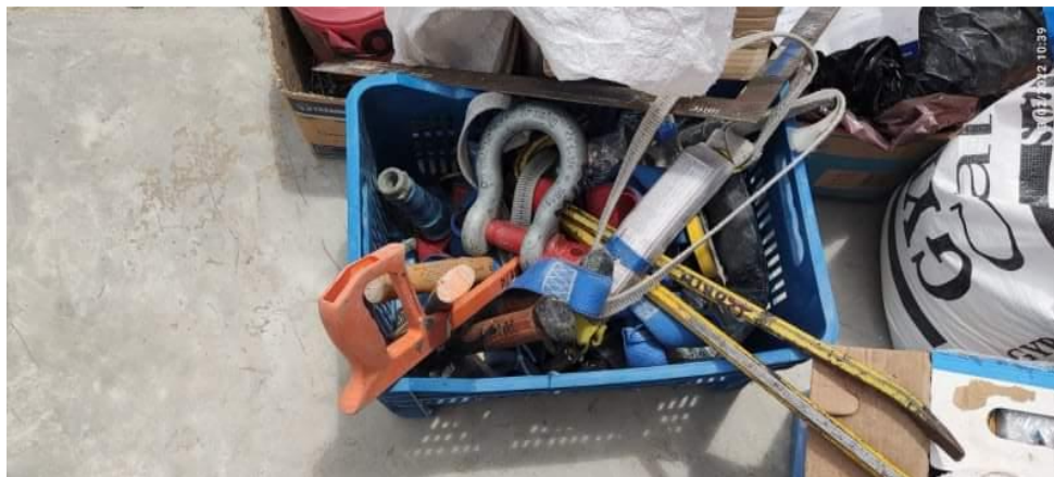
Figura 12 Materiales dejados en el piso que incomodan la circulación
