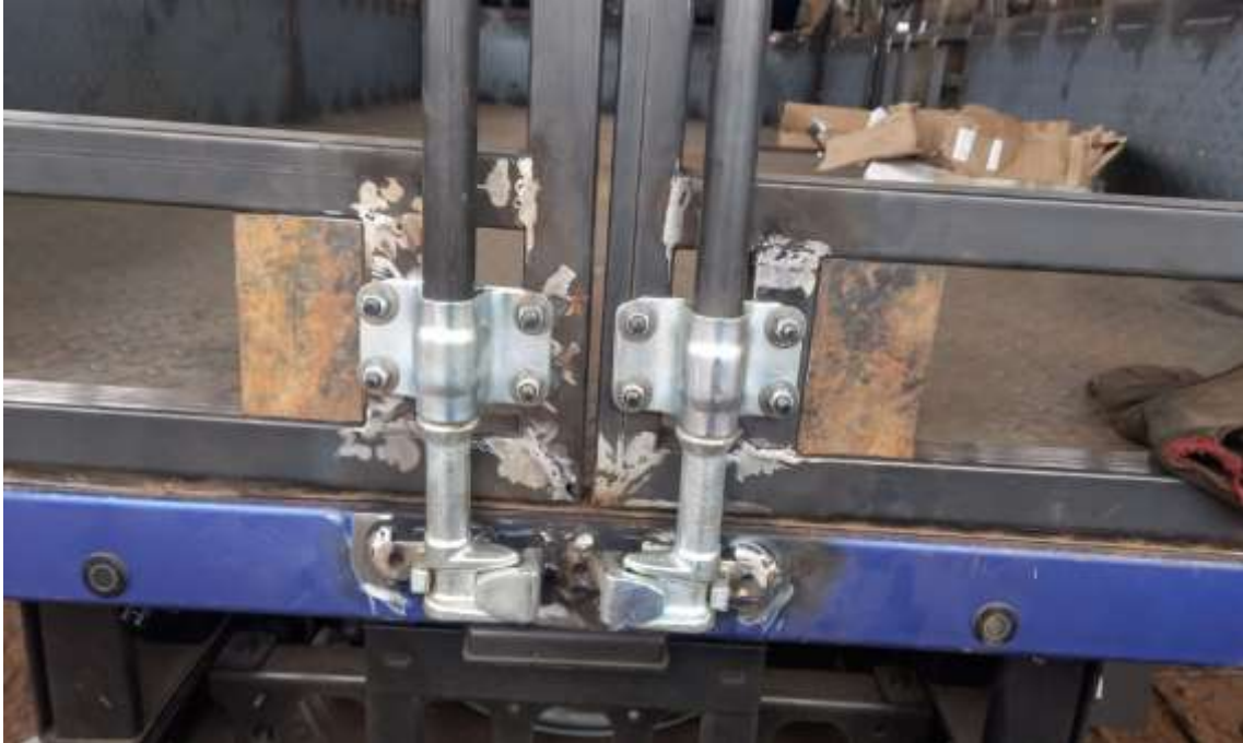
Figura 53. Evidencia del estado de trabajo en la soldadura terminada
