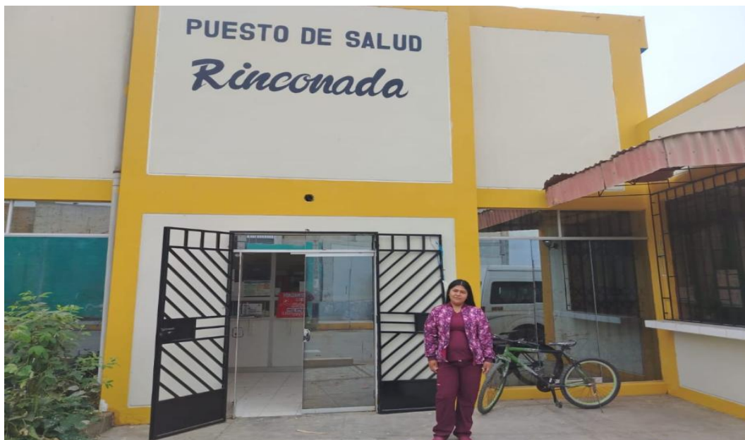
Foto 01: Autora en la puerta principal del puesto de salud “La Rinconada”
